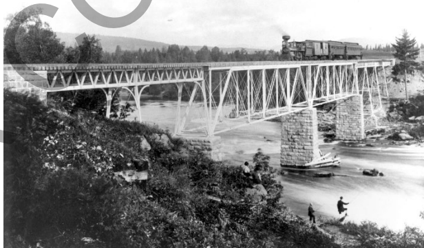
Figure 1 : Pont ferroviaire de Shannon
