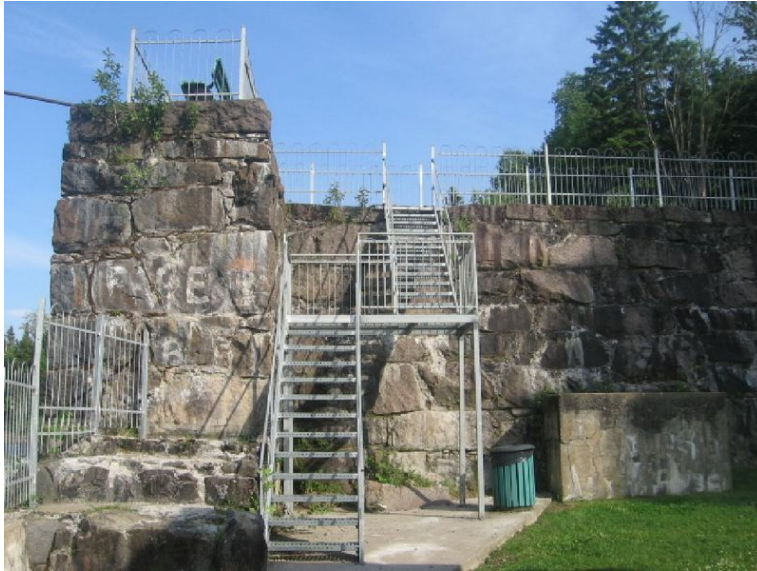
Vestiges de la fondation du « Bulk Head » – Source : Patri-Arch Avec l'autorisation de la MRC de La Jacques-Cartier
