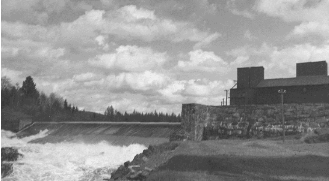
Barrage de gravité et « Bulk Head »– Source : Archives de la Ville de Shannon
