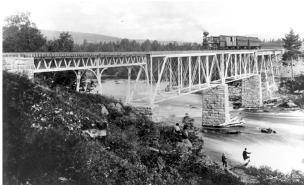
Figure 1 : Pont ferroviaire de Shannon
