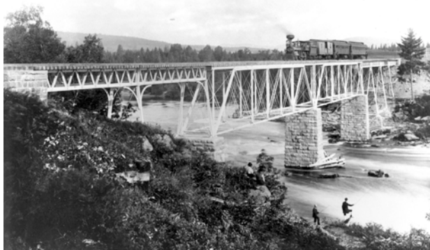
Figure 1 : Pont ferroviaire de Shannon
